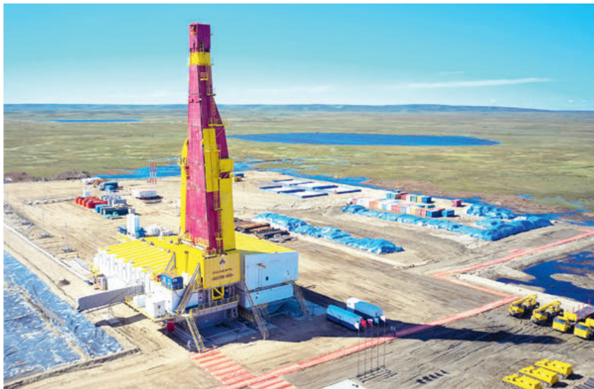
Эксплуатационное бурение ведется на пяти кустах Пайяхского месторождения с применением уникальных буровых комплексов, выполненных в северном исполнении.
