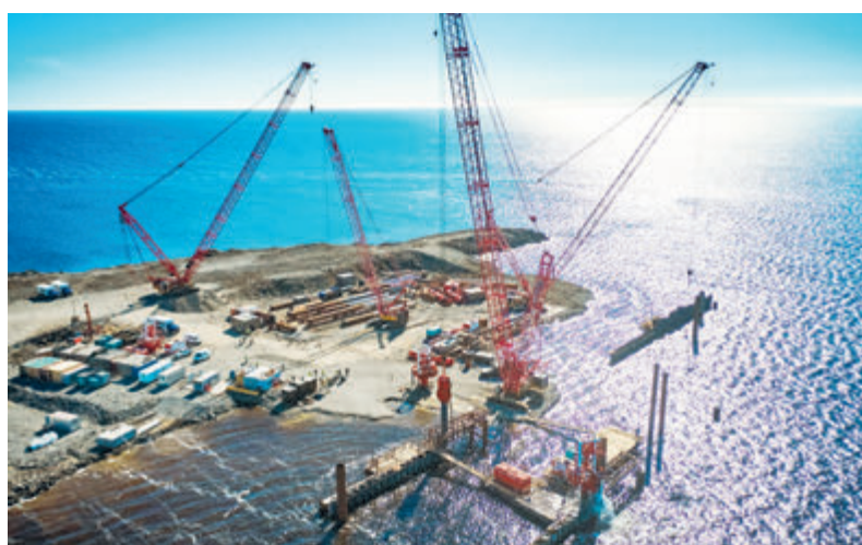
«Роснефть» приступила к строительству крупнейшего приемосдаточного пункта нефти и основного грузового причала для морских судов в порту «Бухта Север».
