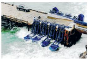
станции в мире. Ее дизайн специфичный: генераторы не плавают где-то в море, а закреплены на причалах и дамбах. Таким образом они в полной мере могут использовать силу морского прилива. При этом не нужно возиться с подводными кабелями, что позволяет существенно снизить
