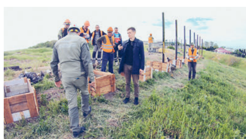
«Вид на древнегреческий город» обещала реклама ЖК «Вершина успеха». Севастопольцы прозвали этот дом «вершиной позора». Но стройка продолжается...
