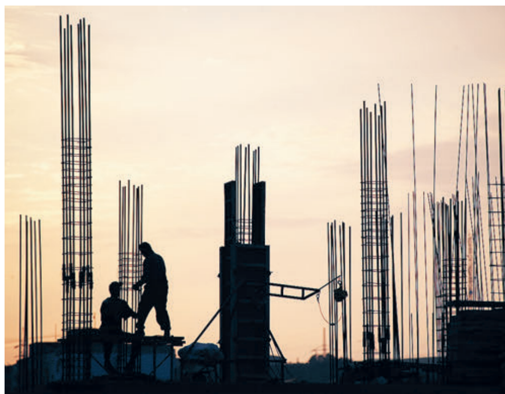
А это Новороссийск, строительный пейзаж. Осталось поставить стены...
