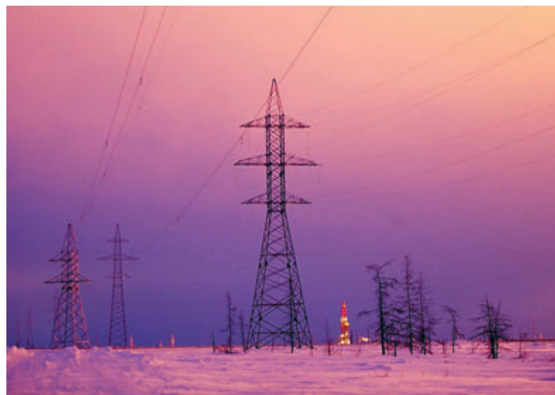
Автономное энергоснабжение объектов проекта будет обеспечиваться собственными электростанциями общей мощностью порядка 3,5 ГВт.
