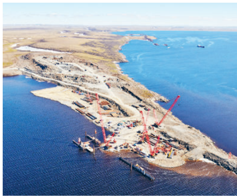
В 2022 году «Роснефть» приступила к строительству уникального порта «Бухта Север» в Енисейском заливе на западе полуострова Таймыр.
