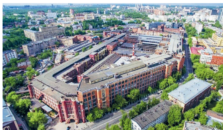
Так выглядит Электрозавод сегодня – и таким предстанет это место по замыслам застройщиков.
