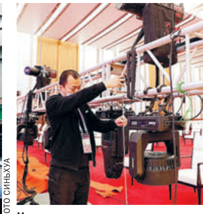
Наладка светотехнического оборудования накануне открытия СИЕ-2020.
