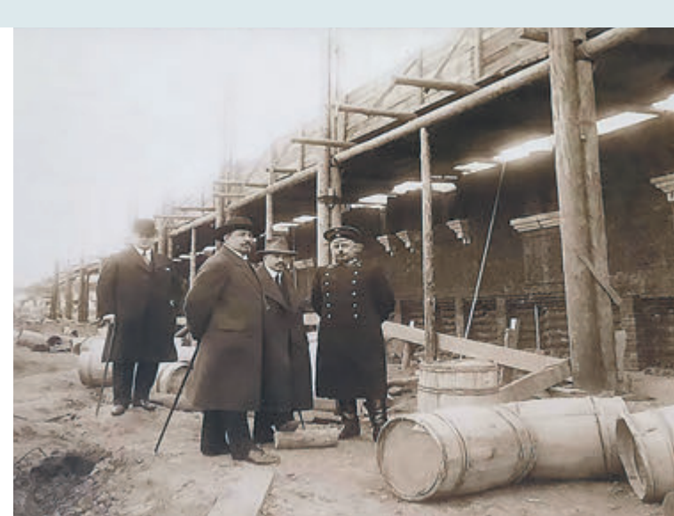
Алексей Щусев на строительстве Казанского вокзала. Его эскизы – настоящие художественные произведения.
