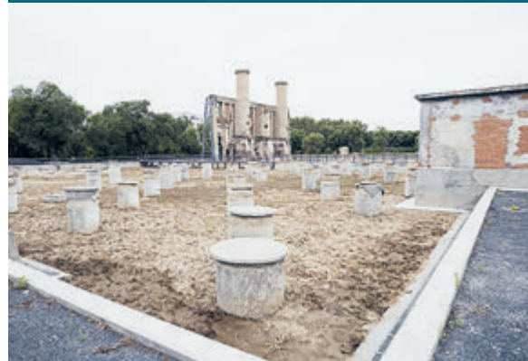
Развалины котельной установки «отряда 731» в городе Харбине.
