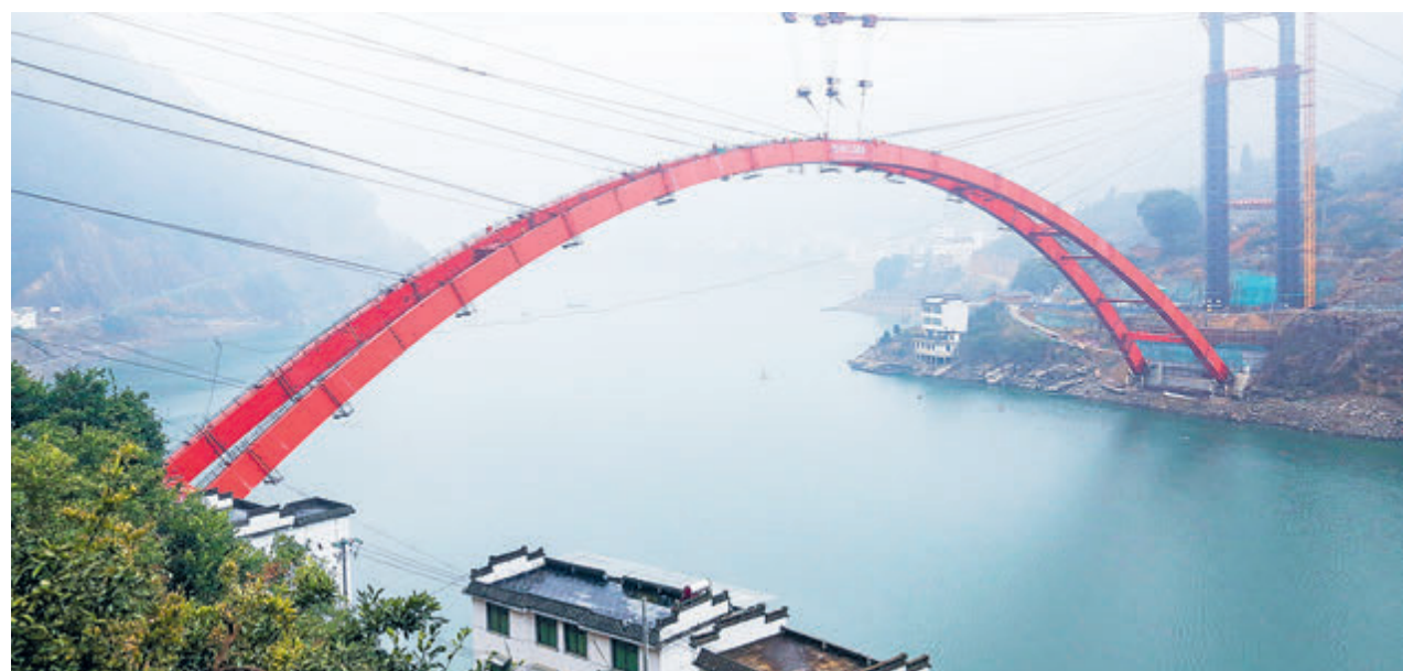
В городе Хуаншань провинции Аньхой строится арочный мост через реку Синьань.
